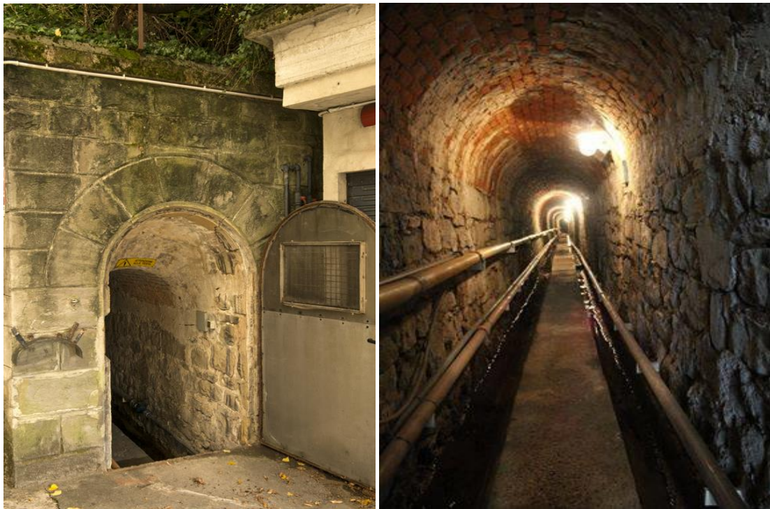
Fig.7- La galleria delle sorgenti
